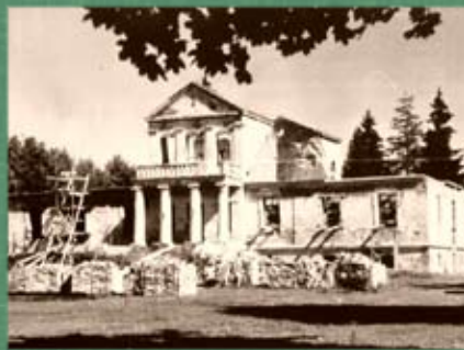
Odbudowa dworu w latach 1959-1962
