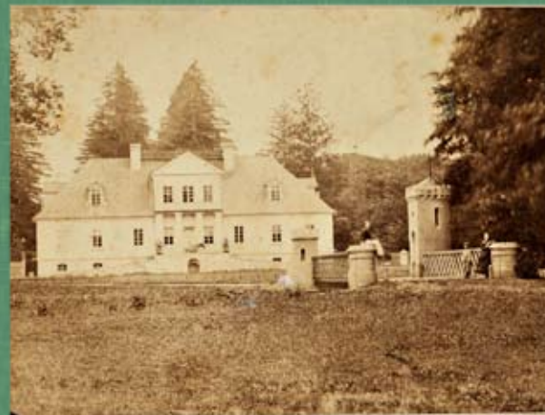
Dwór z II połowy XIX wieku, po przebudowie
