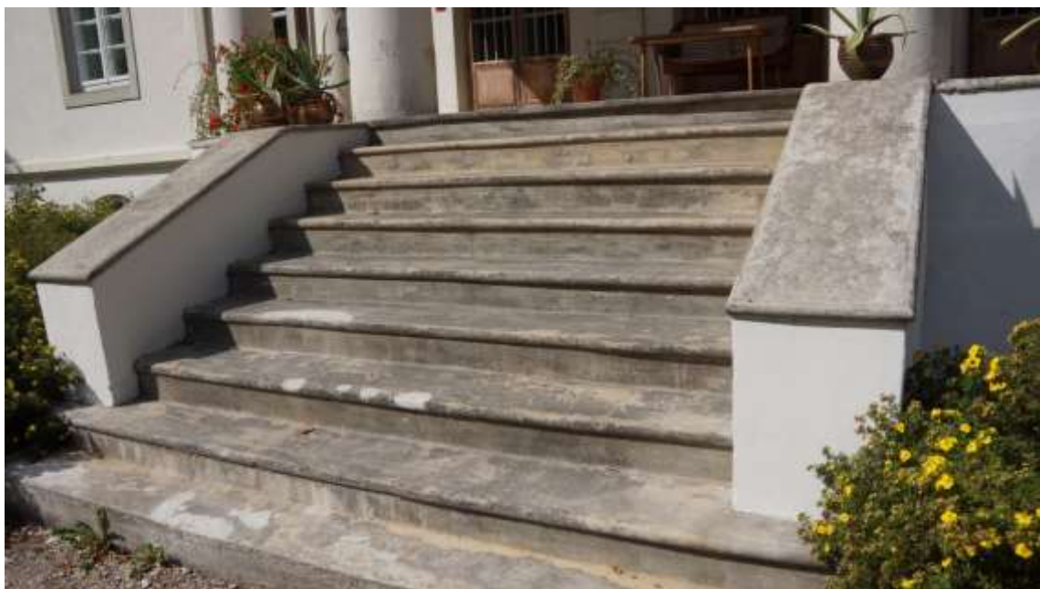
Widok na schody od strony wschodniej
