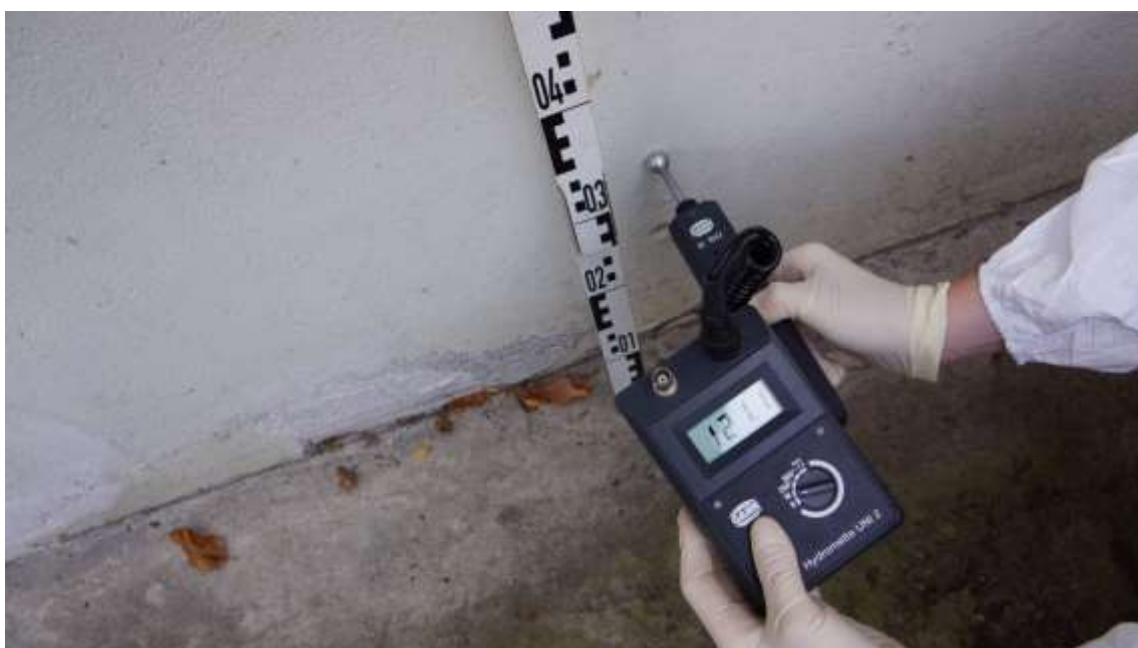
Pomiar wilgotności ściany – mur bardzo mokry
