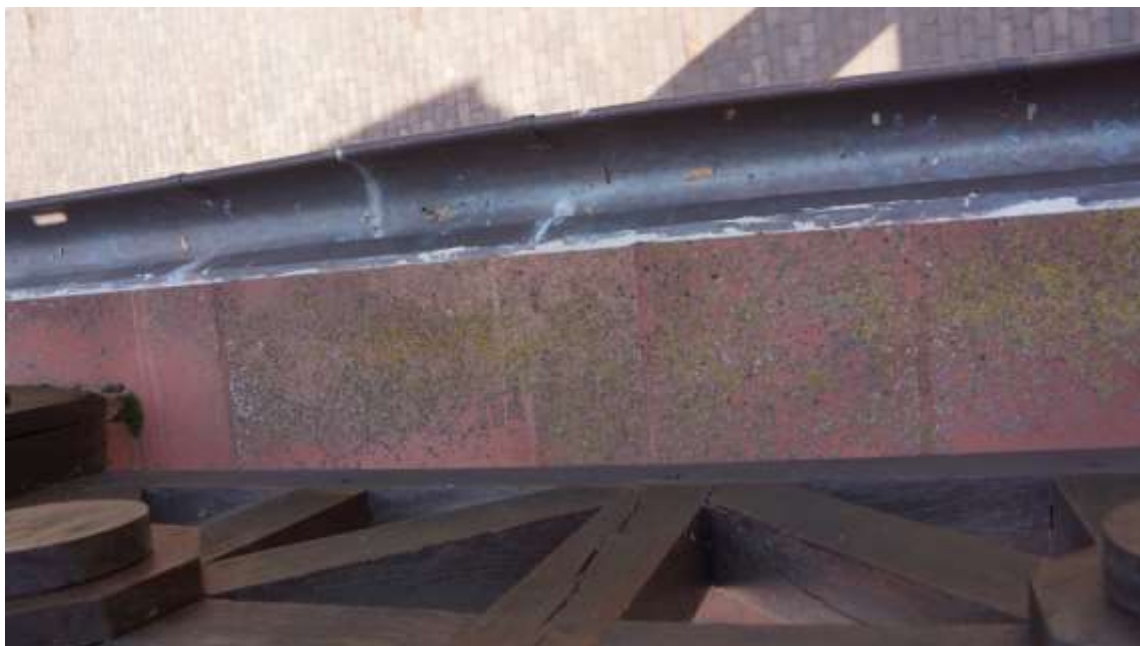
Zjawisko biofoulingu, czyli pokrywania powierzchni mikroorganizmami
