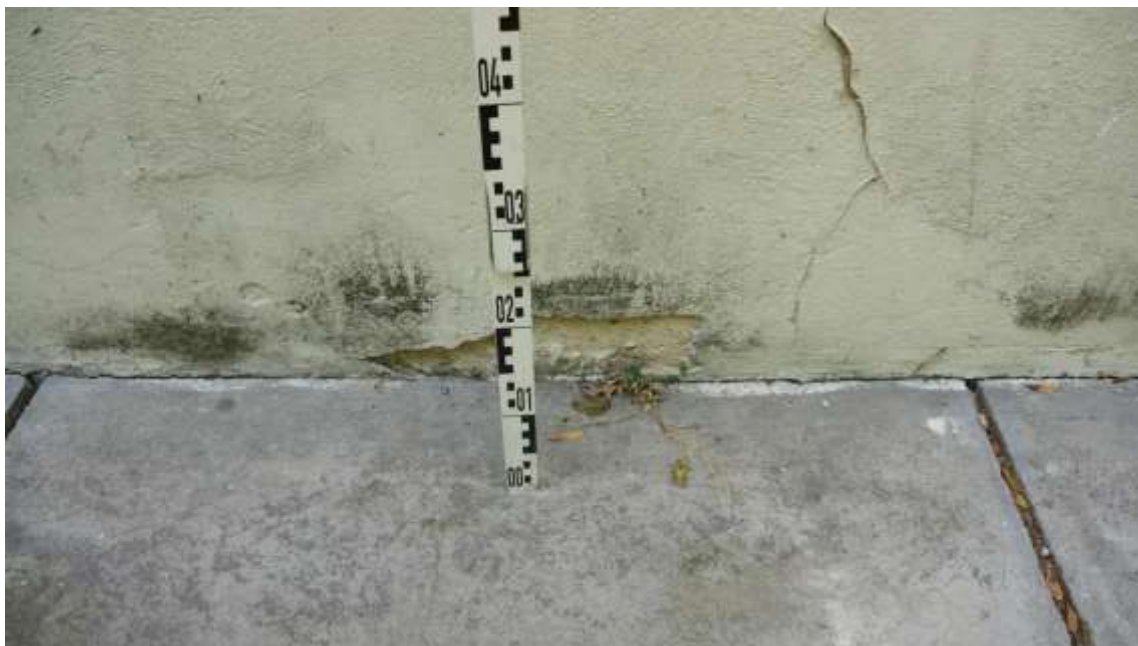
Ubytki i spękania powłoki malarskiej na elewacji
