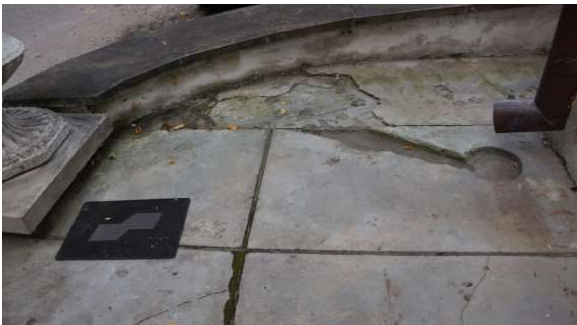
Widoczny stan opaski przy południowo – zachodnim narożniku dworu
