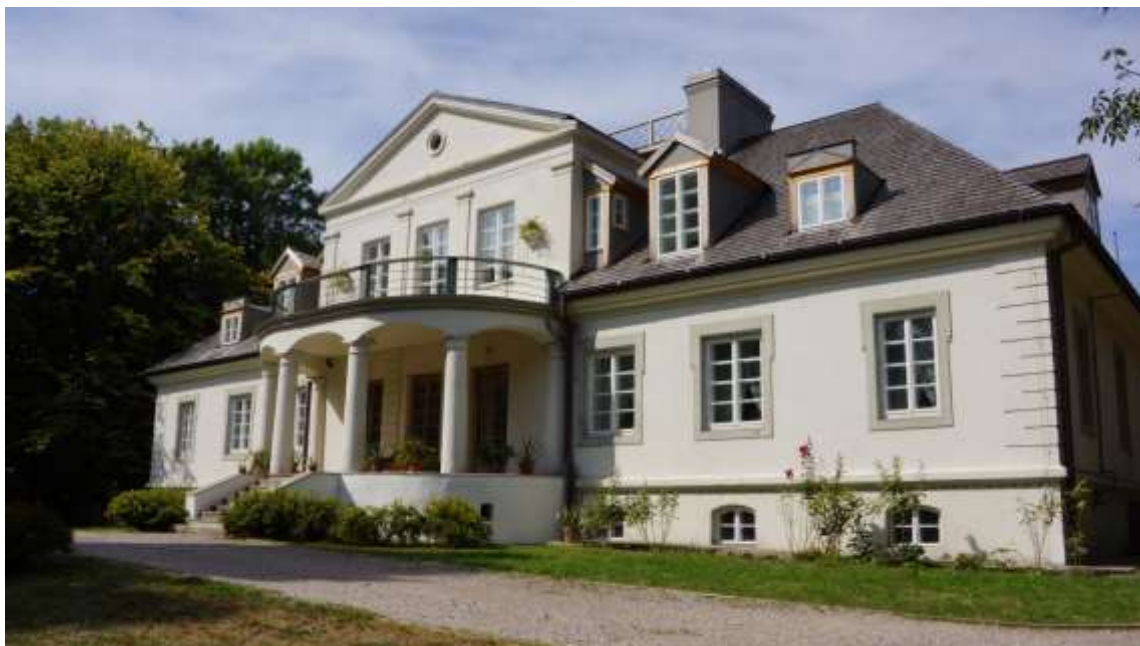
Widok ogólny na elewację wschodnią
