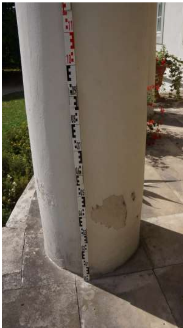
Odspojony tynk na kolumnie, złuszczenia powłok malarskich
