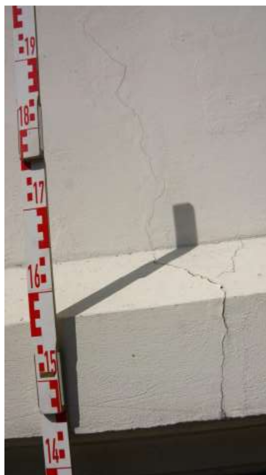
Kolejne spękanie tynku na elewacji
