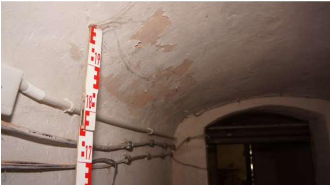
C.d. korytarza piwnicznego z widocznym odspojeniem powłoki malarskiej.
