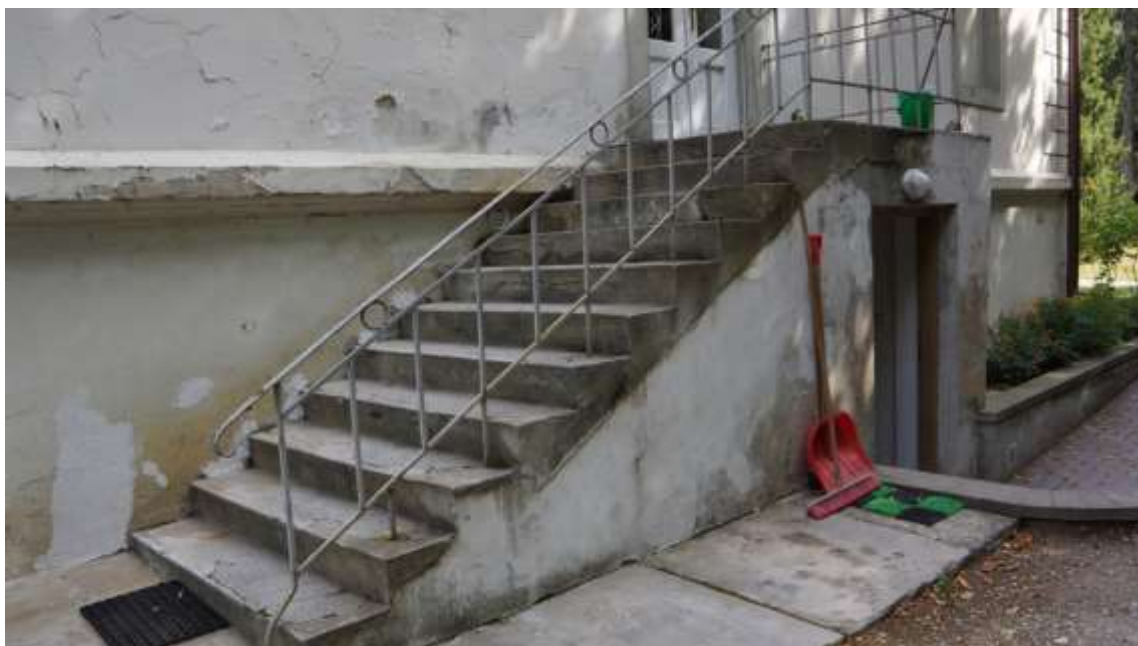
Schody prowadzące na kondygnację parteru, pod nimi znajduje się jedno z dwóch wejść na poziom piwnic.
