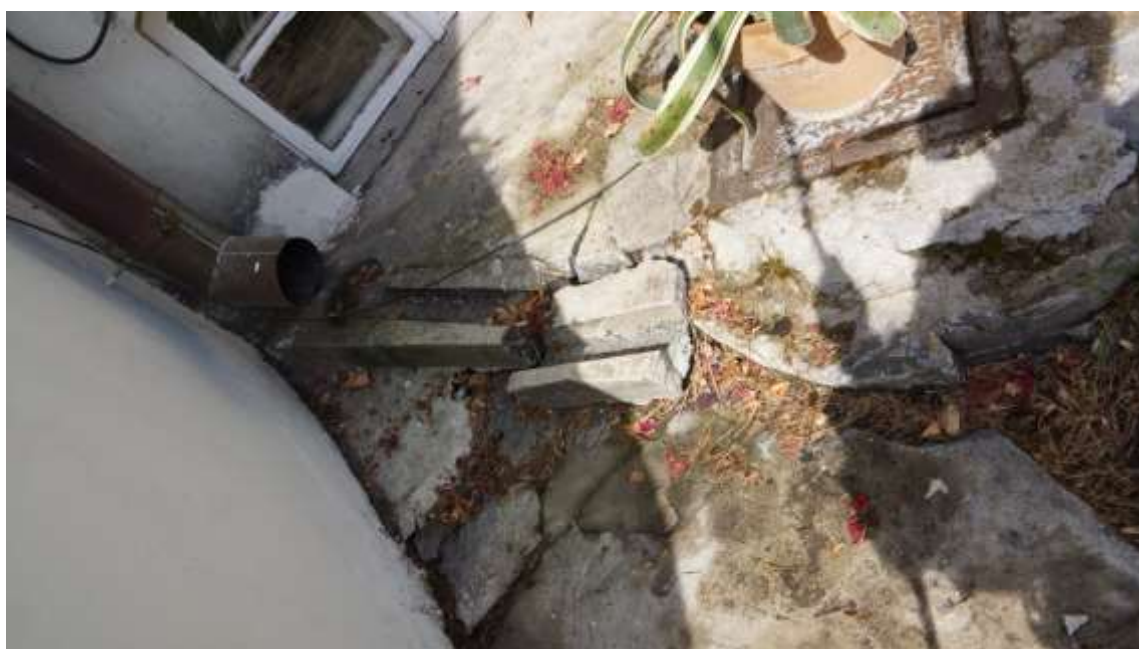
Destrukcja opaski przy budynku powoduje wnikanie wód (opadowych i omywających elewację) w grunt w bezpośrednim sąsiedztwie budynku.
