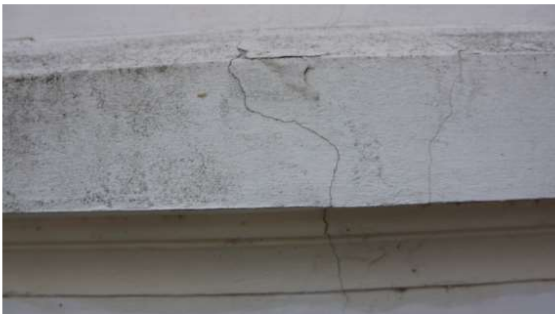
Spękania gzymsu nad cokołem
