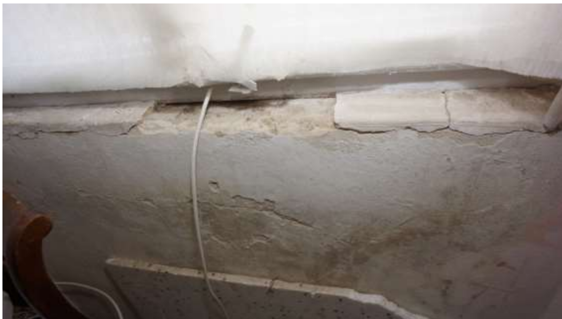
Zbliżenie na fragment ściany pod oknem – spękany tynk, powłoka malarska oddzielona od tynku
