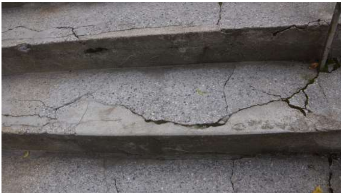
Liczne spękania płyt lastrykowych, z których wykonane są schody
