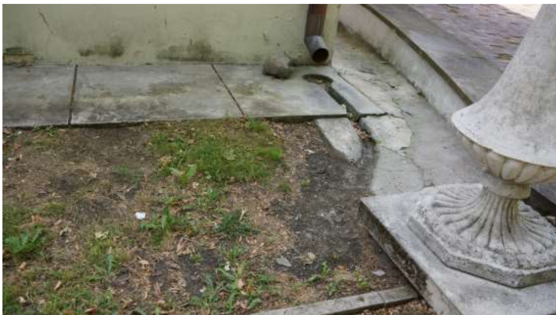
Korozja biologiczna cokołu. Nieszczelna opaska przy budynku
