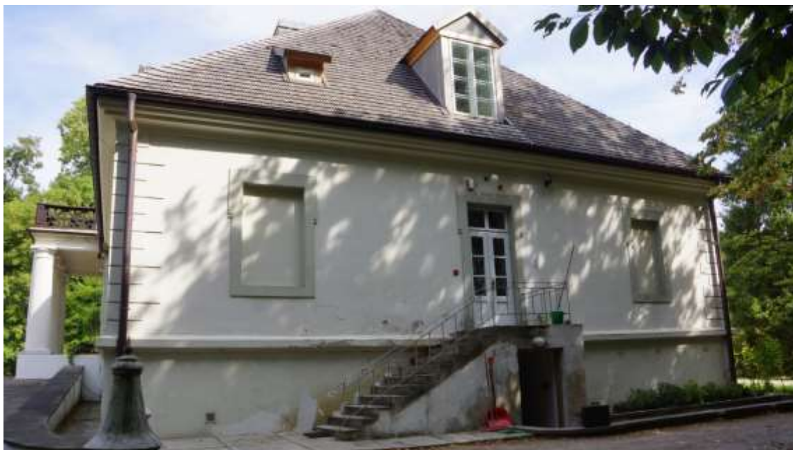
Widok ogólny na elewację południową.
