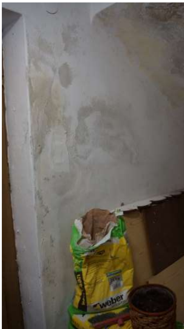
Zniszczenia tynku na ścianie zewnętrznej budynku
