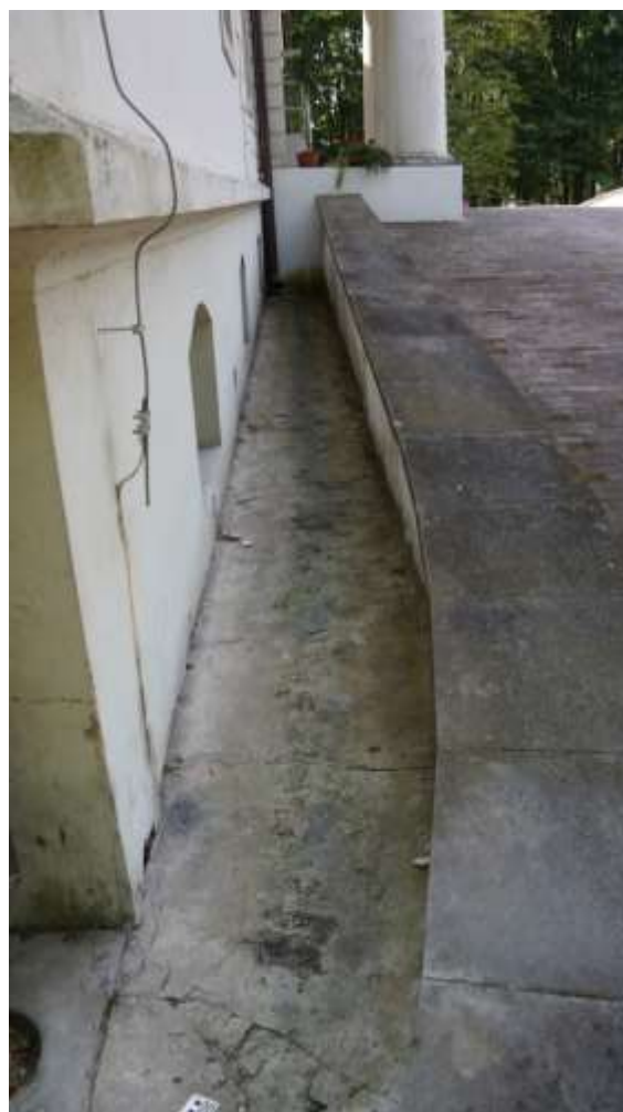
Zarówno opaska, jak i cokół wokół budynku ulegają degradacji biologicznej
