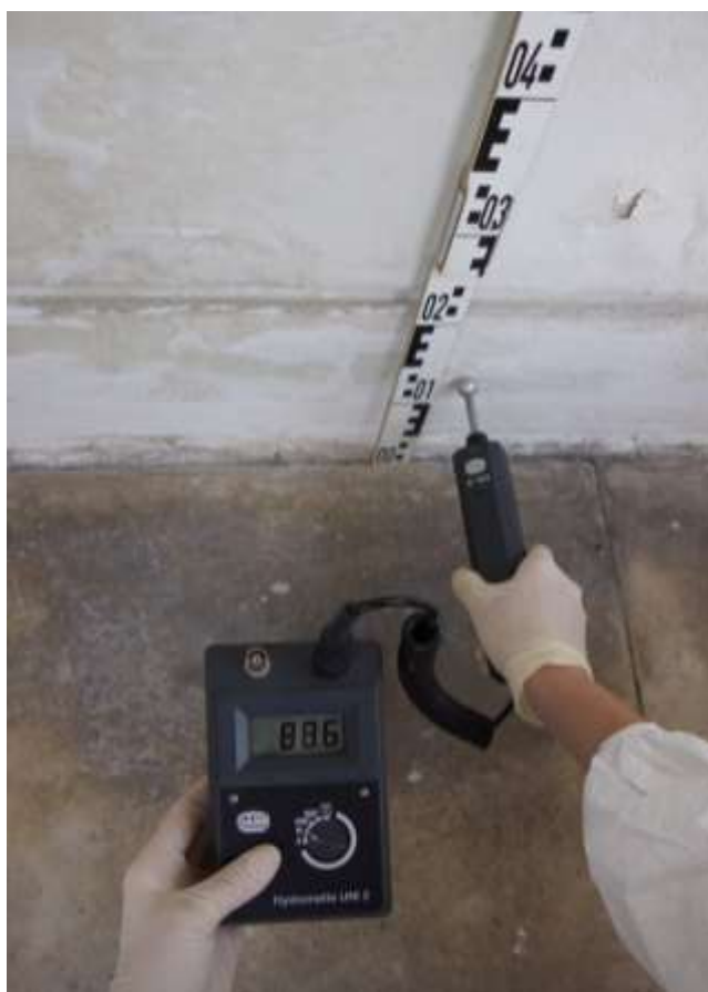
Pomiar wilgotności ściany nad tarasem. Wynik podwyższony. Mur wilgotny
