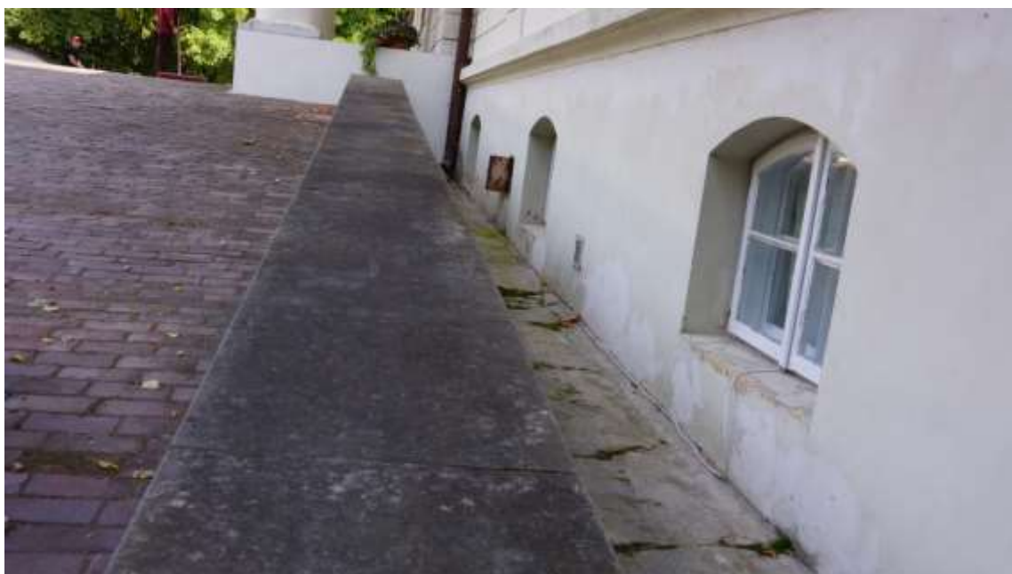
Elewacja zachodnia – widok na okna piwniczne
