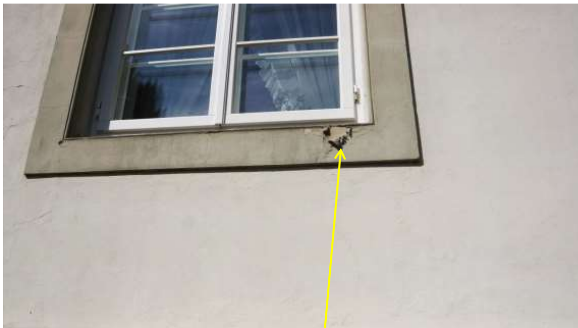
Złuszczenie farby na ozdobnej ramie okna
