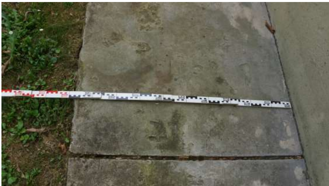
Szerokość istniejącej opaski: 97 cm
