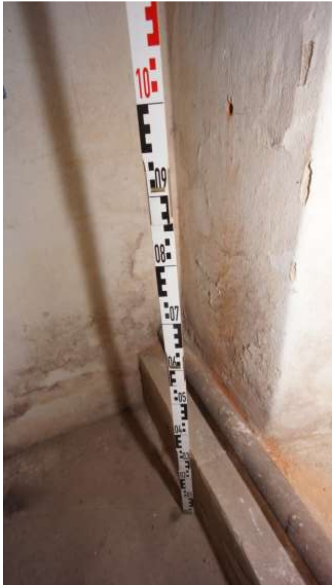
Ubytki powłok malarskich i korozja tynku.
