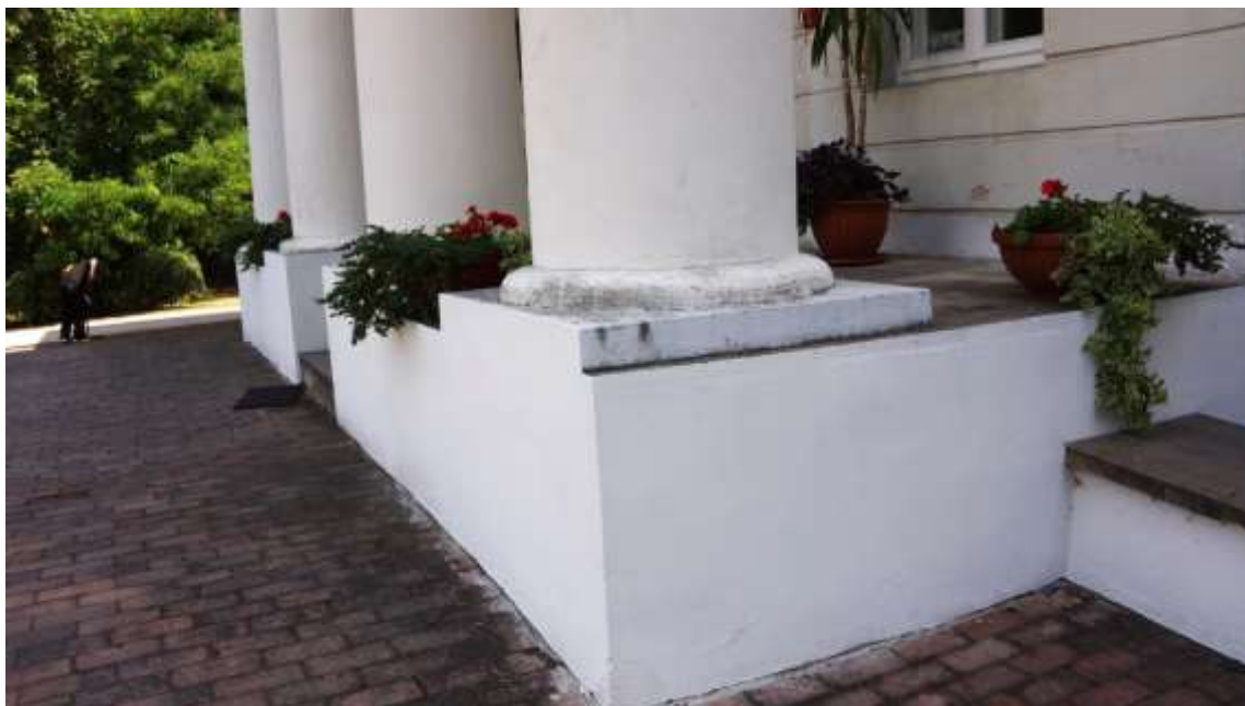
Widok ogólny na taras przy wejściu do budynku. Przy podstawie kolumny zielony nalot, świadczący o postępującej korozji biologicznej.
