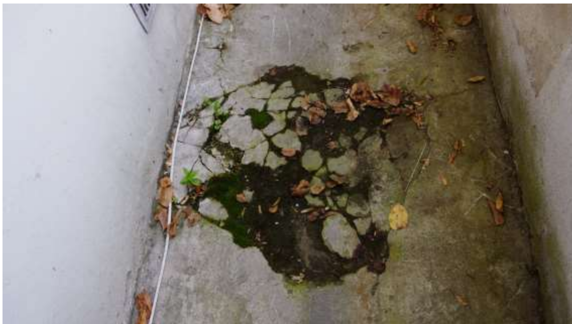
Widoczna destrukcja opaski przy budynku oraz zawilgocenie murku oporowego, pochodzące m.in. od rozbryzgów wody opadowej.
