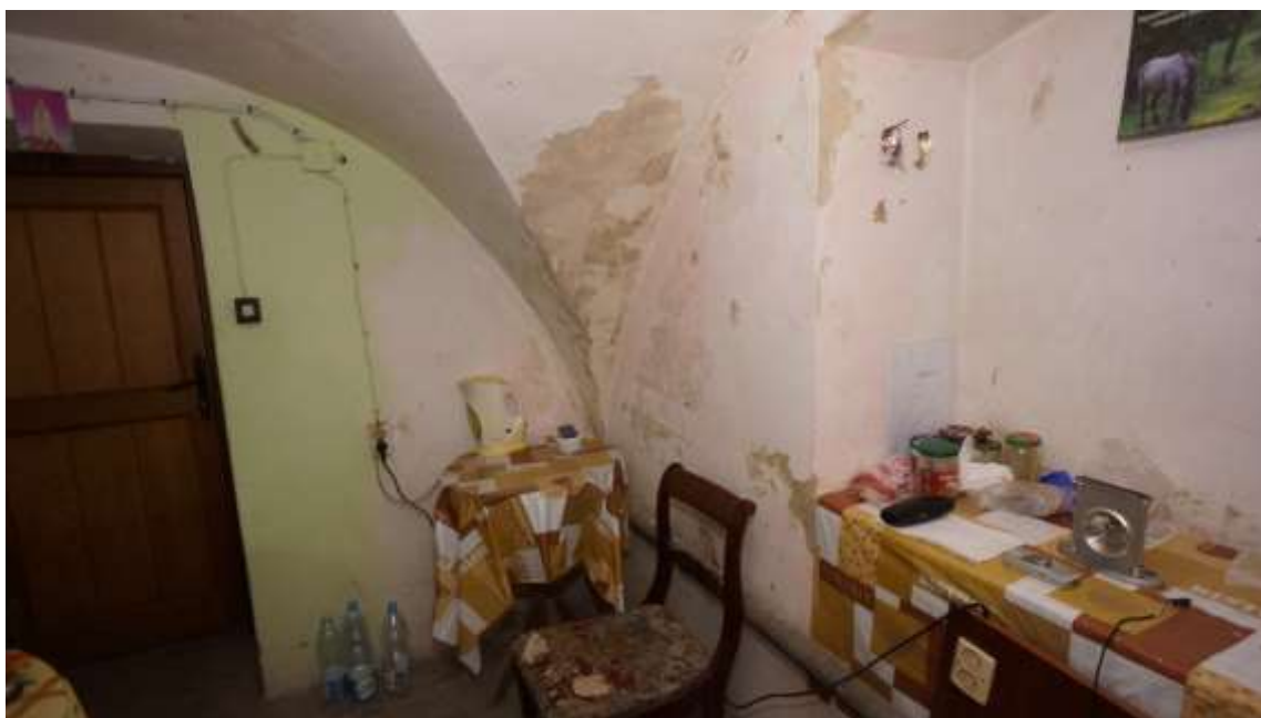
Spurchlenia i ubytki powłok malarskich
