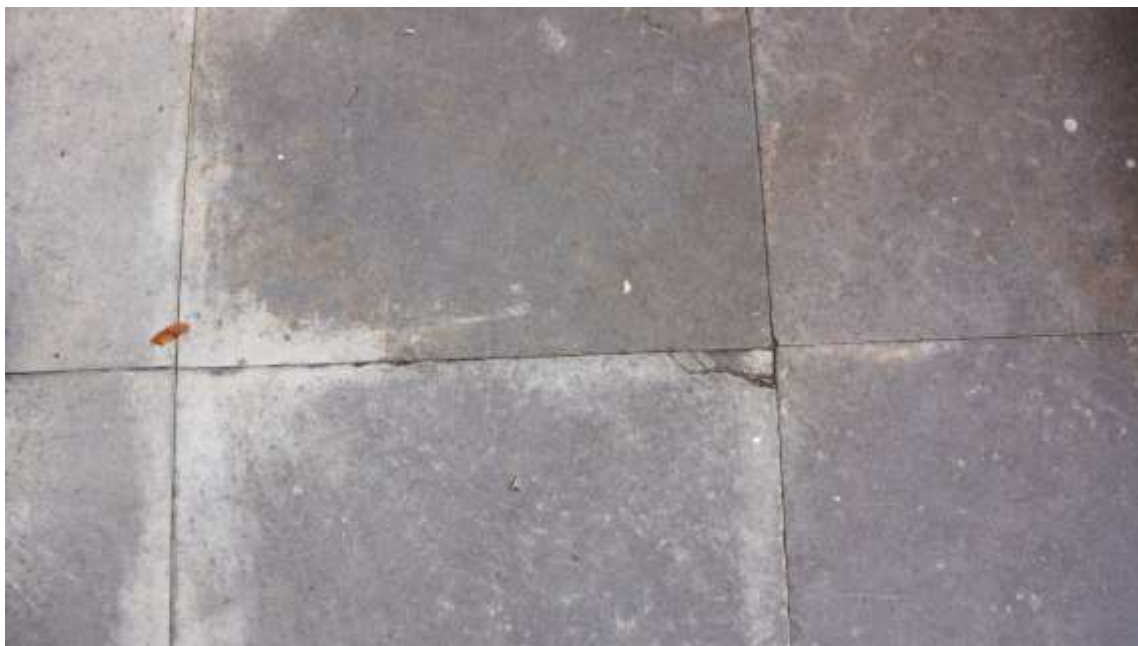
Spękania płyt, stanowiących wykładzinę tarasu
