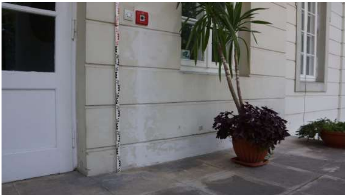
Na ścianie nad tarasem liczne przebarwienia i złuszczenia tynku
