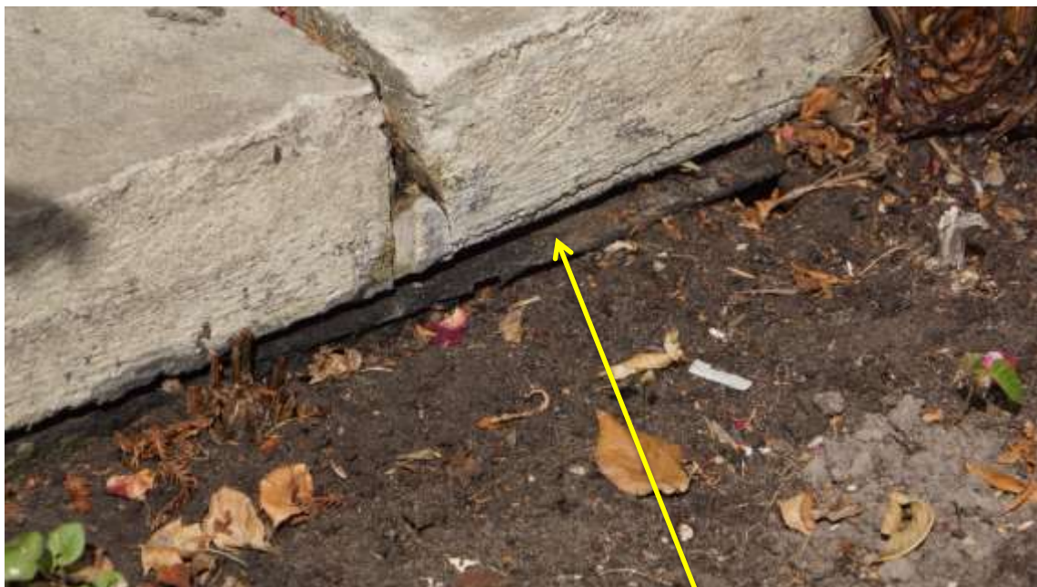
Widoczna warstwa papy pod betonową opaską
