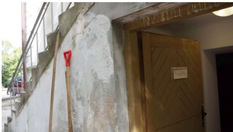
Ściany pomieszczenia pod schodami zniszczone w wyniku oddziaływania mikroorganizmów oraz soli budowlanych
