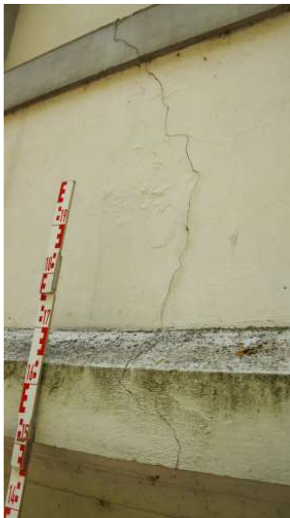
Pęknięcie poziome na ścianie pod oknem
