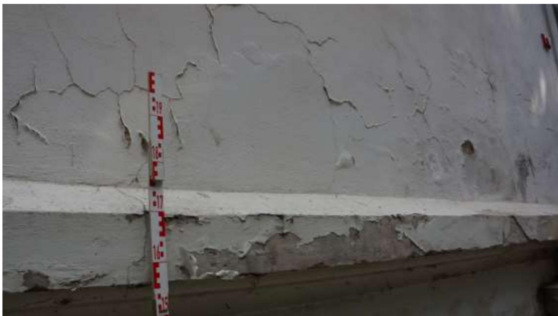
Surchlenia powłok malarskich na ścianie od strony południowej
