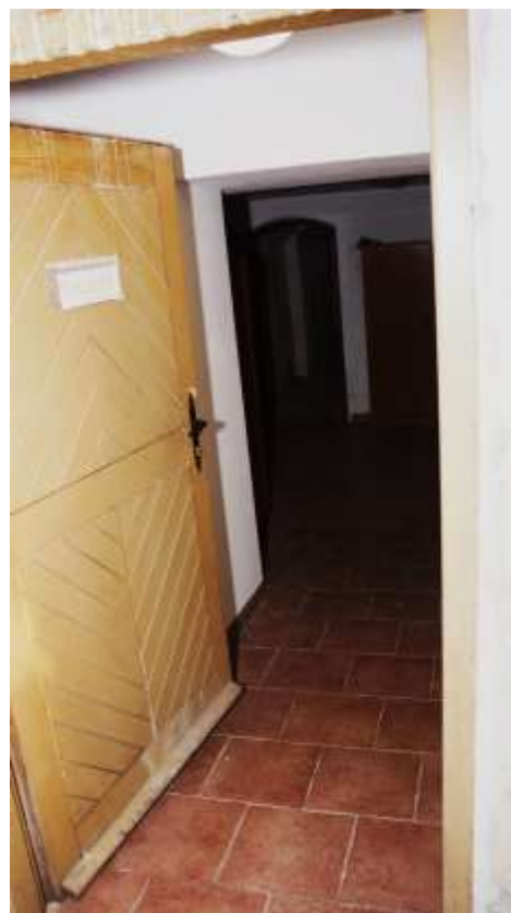
Widok ogólny na wejście do piwnic od strony południowej
