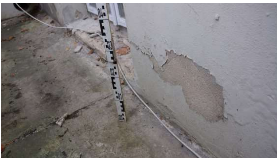
Ubytki powłoki malarskiej na wysokość ok. 40cm
