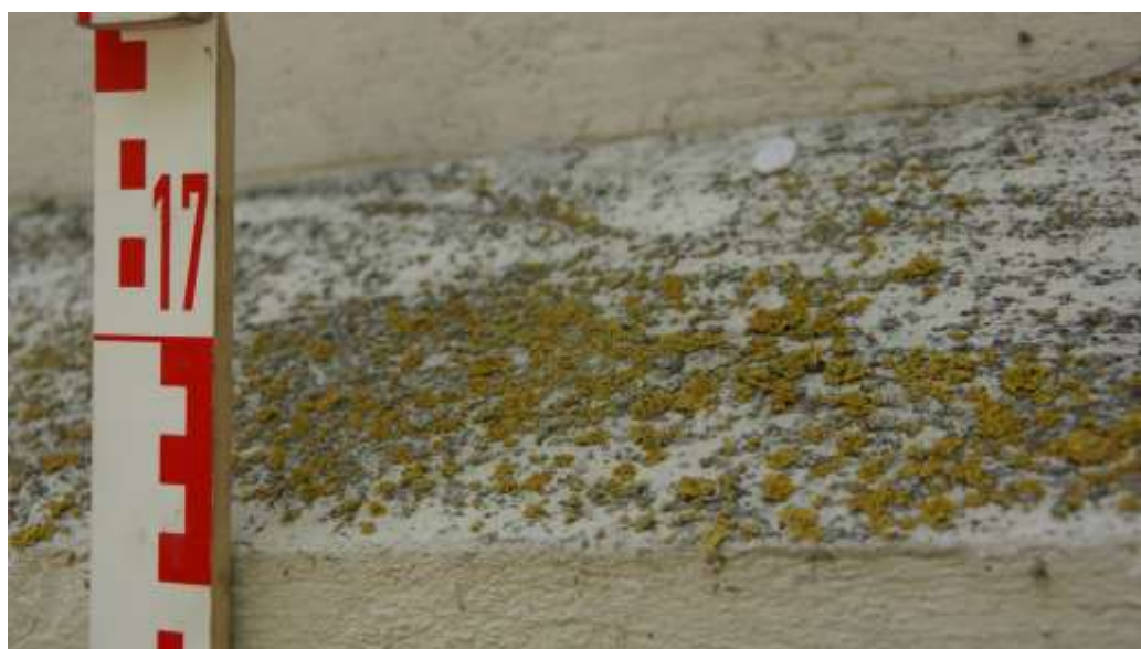
Nierówności tynku, jak również zmienne warunki atmosferyczne, są sprzyjającym środowiskiem dla rozwoju porostów.
