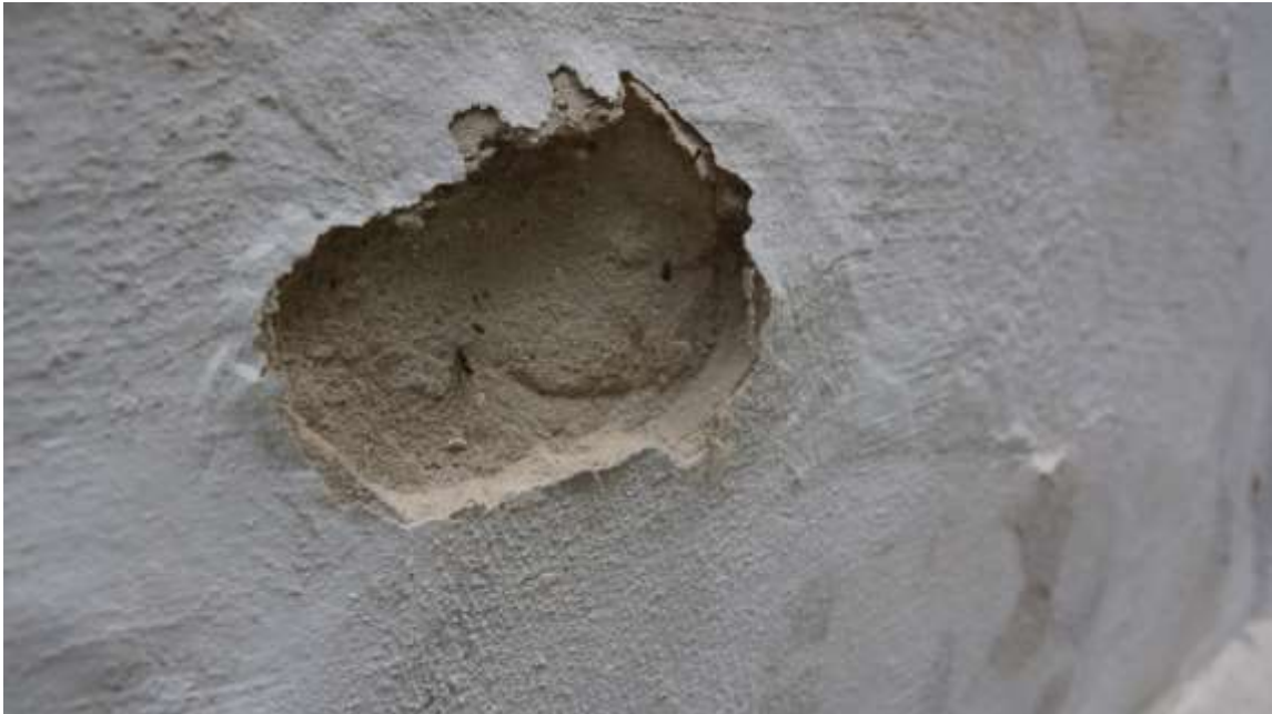
Zbliżenie na odparzony i kruszejący tynk, jest to spowodowane krystalizowaniem się soli budowlanych
