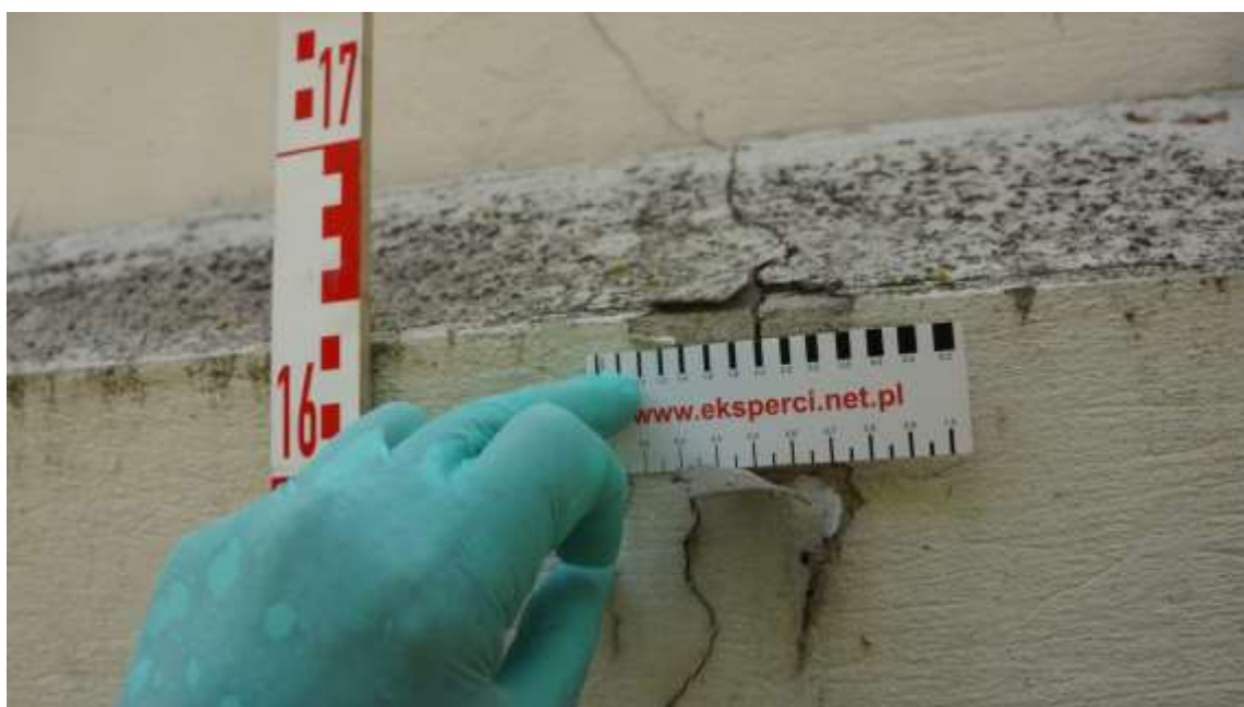
Pęknięcie muru o szerokości 2 mm
