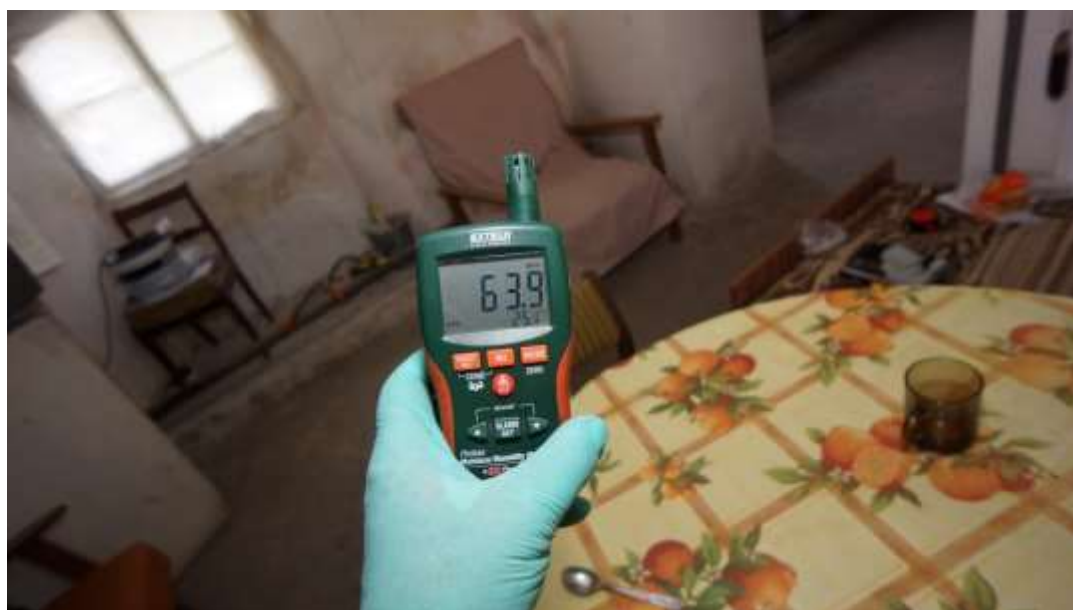
Warunki, w jakich odbywała się wizja i pobór próbek na obiekcie, to: temp. powietrza 25,1 °C, jego wilgotność – 63,9 %.
