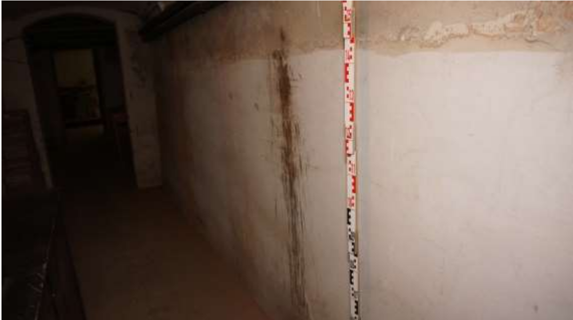
C.d. korytarza piwnicznego z widocznymi ubytkami tynku i wysoleniami
