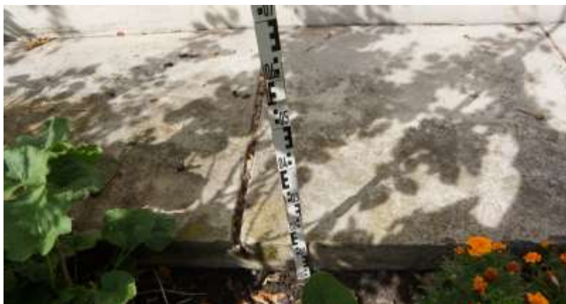
Wysokość opaski przy budynku wynosi ponad 10 cm.
