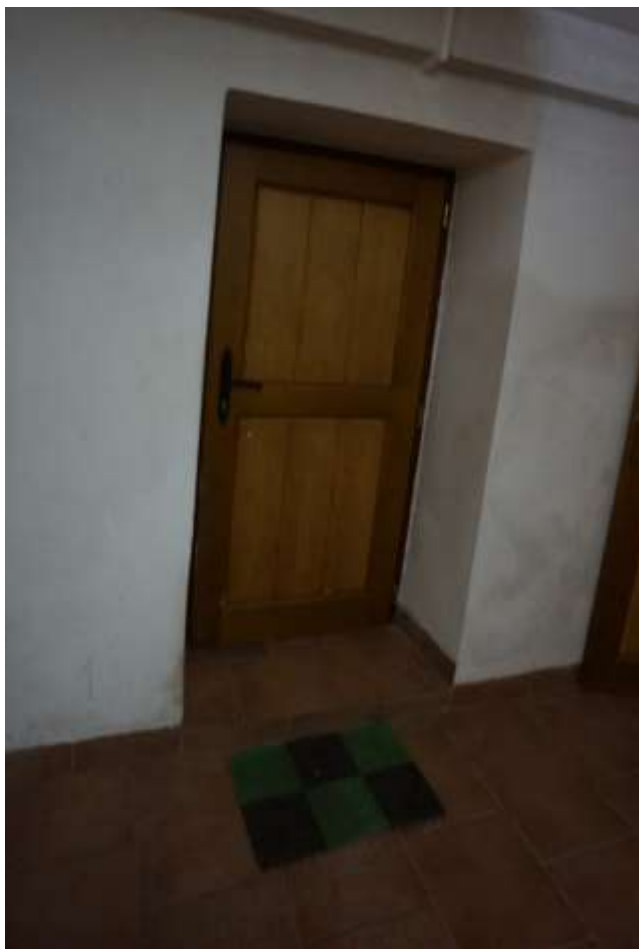
Na ścianie za drzwiami widoczna linia podciągania kapilarnego wody
