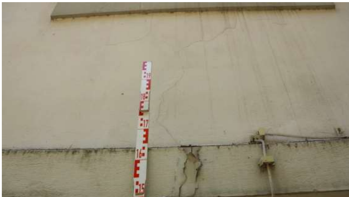
Zarysowania muru sięgają powyżej 2 m
