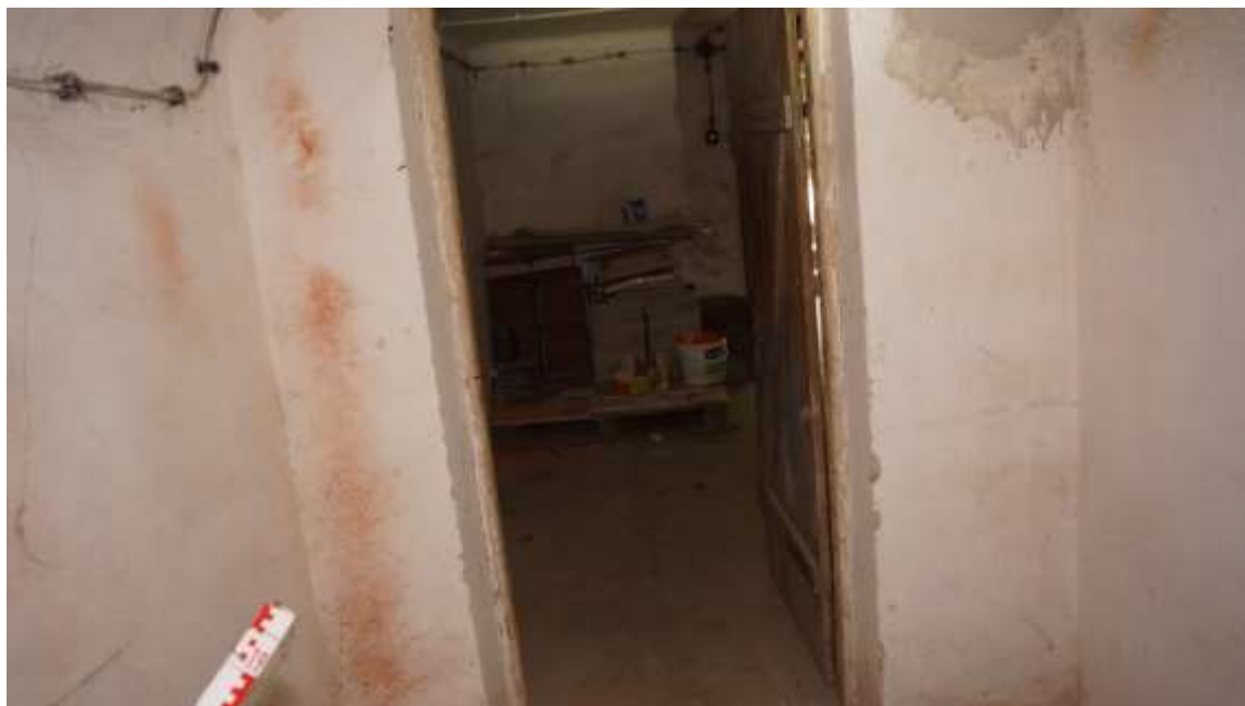
Ostatni fragment korytarza piwnicznego z widocznymi ubytkami tynku i wysoleniami.
