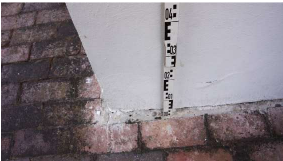
Tynk odspojony i spękany – skutek kapilarnego podciągania wilgoci
