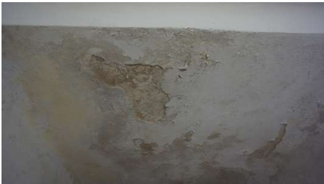
Zbliżenie na wysadzony przez sole tynk
