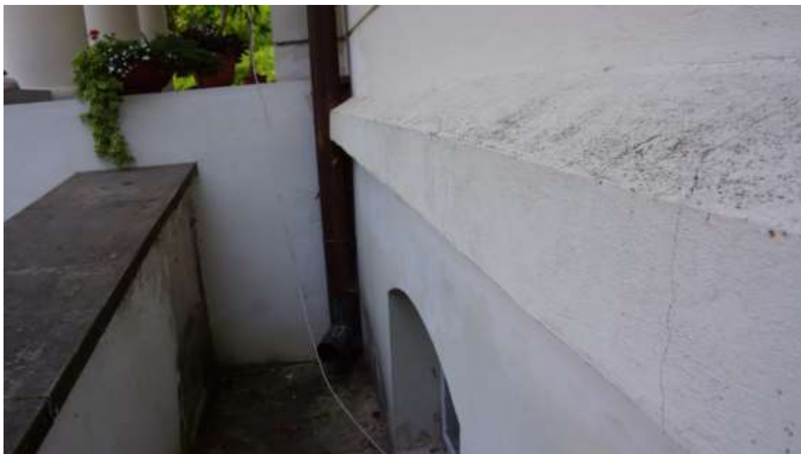
Na tynku z zaprawy cementowej pojawiają się liczne spękania
