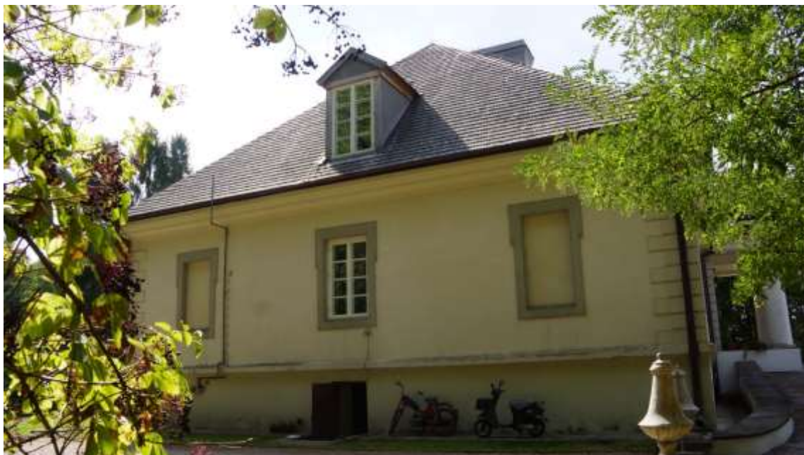
Widok ogólny na elewację północną
