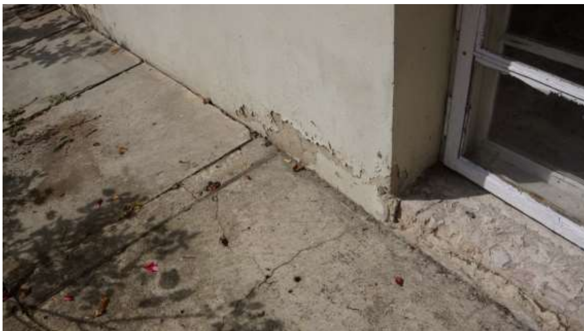
Kolejny przykład korozji tynku parapetu okna piwnicznego spowodowany częstym zalewaniem wodami opadowymi.
