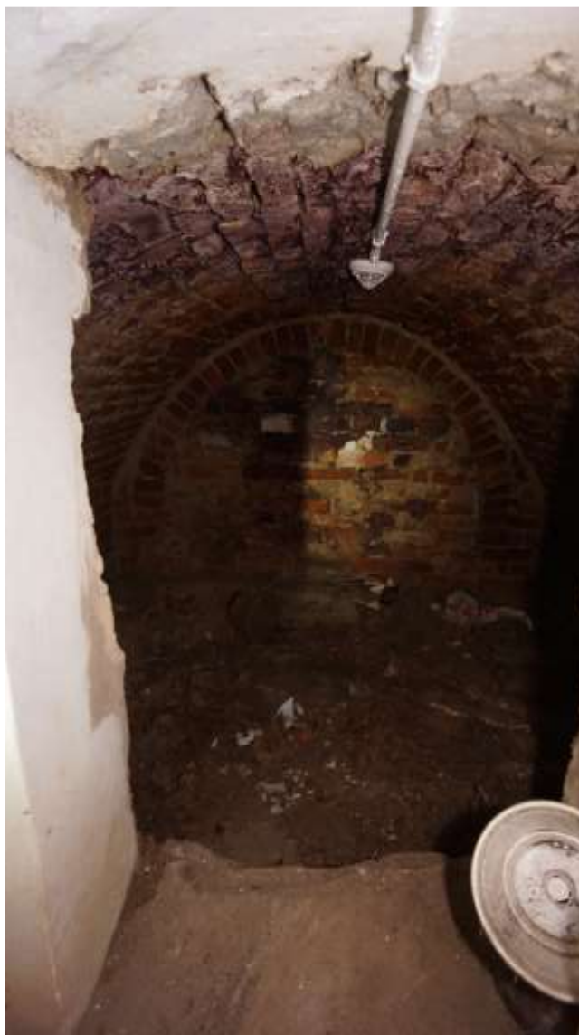
Pomieszczenie pod tarasem od strony zachodniej
