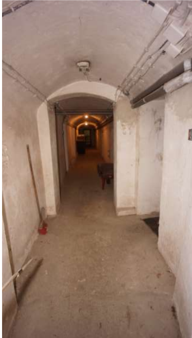
Widok ogólny na korytarz piwniczny
