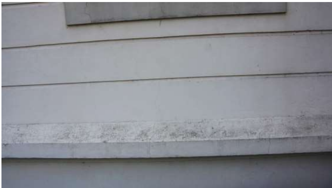
Zarysowania tynku na gzymsie cokołu i opaski przy oknie
