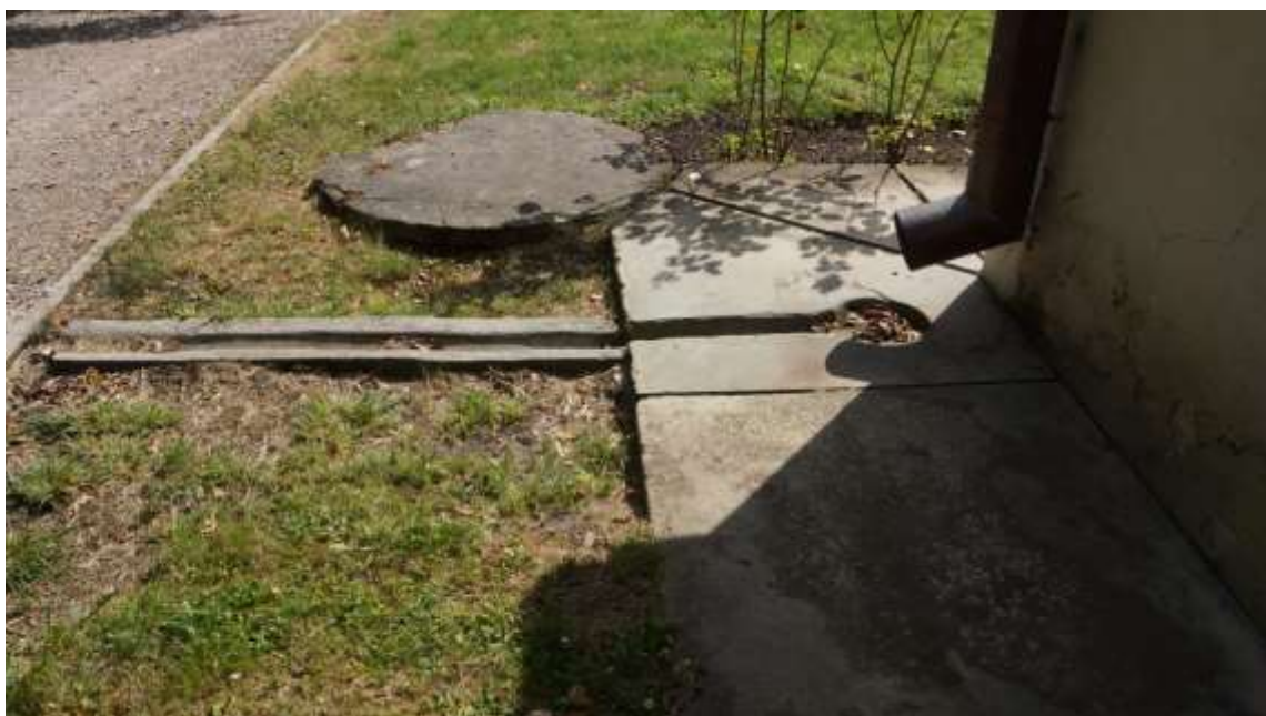
Na ścianie budynku widoczna linia, powstała od rozbryzgów z wody opadowej. W tym miejscu następuje intensywne złuszczenie powłoki malarskiej.
