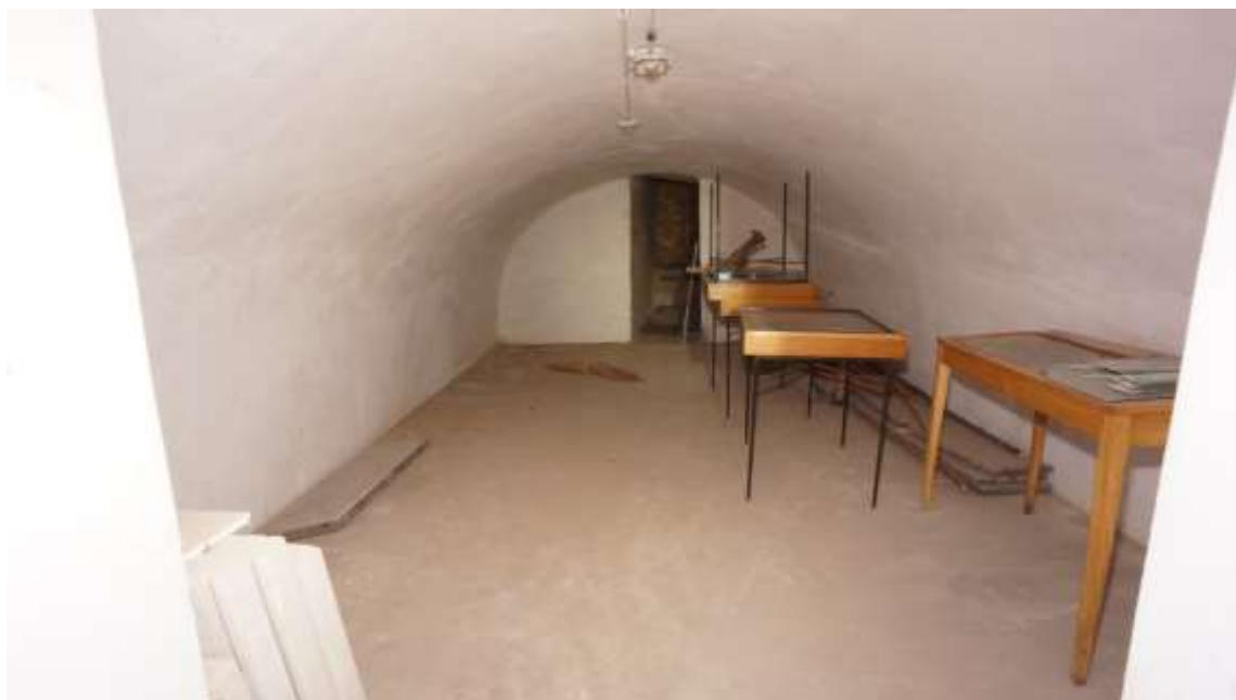
Jedno z pomieszczeń po remoncie z widocznymi już zmianami struktury tynku, wynikającymi z ponownego zawilgocenia muru.
