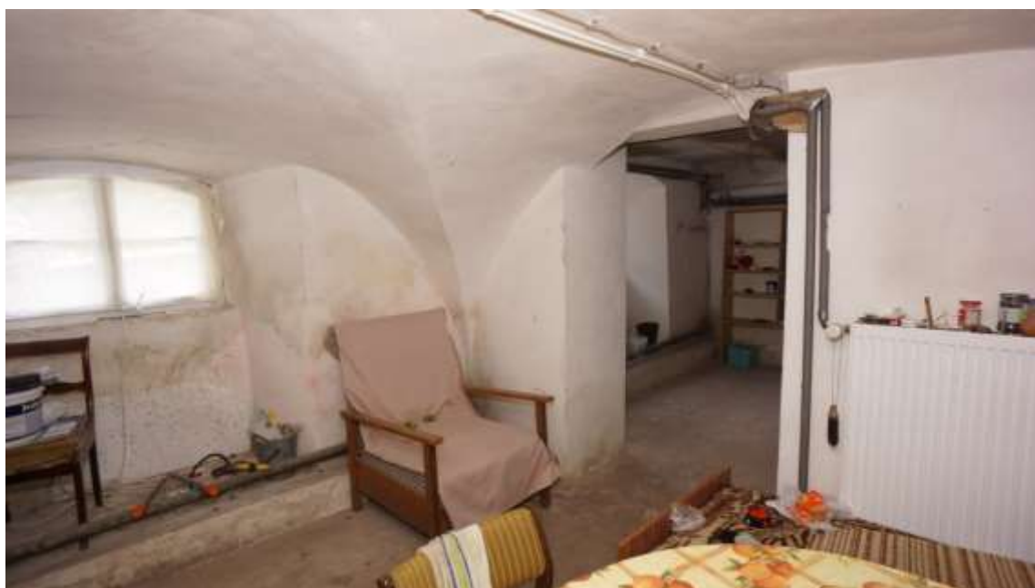
W wyniku silnego zawilgocenia tynk ulega degradacji i pojawiają się wykwity grzybów pleśniowych
