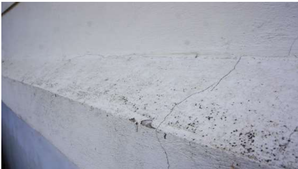
Widoczne spękania, odspojenie farby oraz korozja mikrobiologiczna
