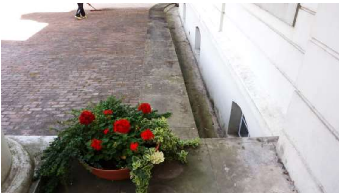
Widok na opaskę przy budynku - od strony tarasu
