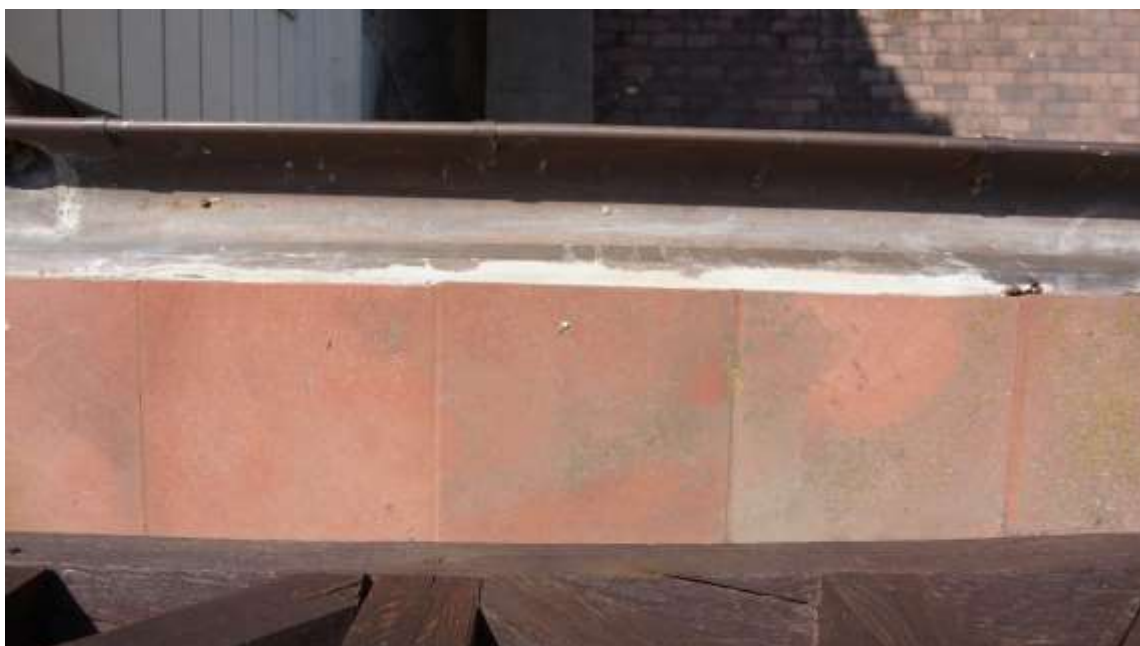
Grzyby pleśniowe oraz glony na płytkach ceramicznych
