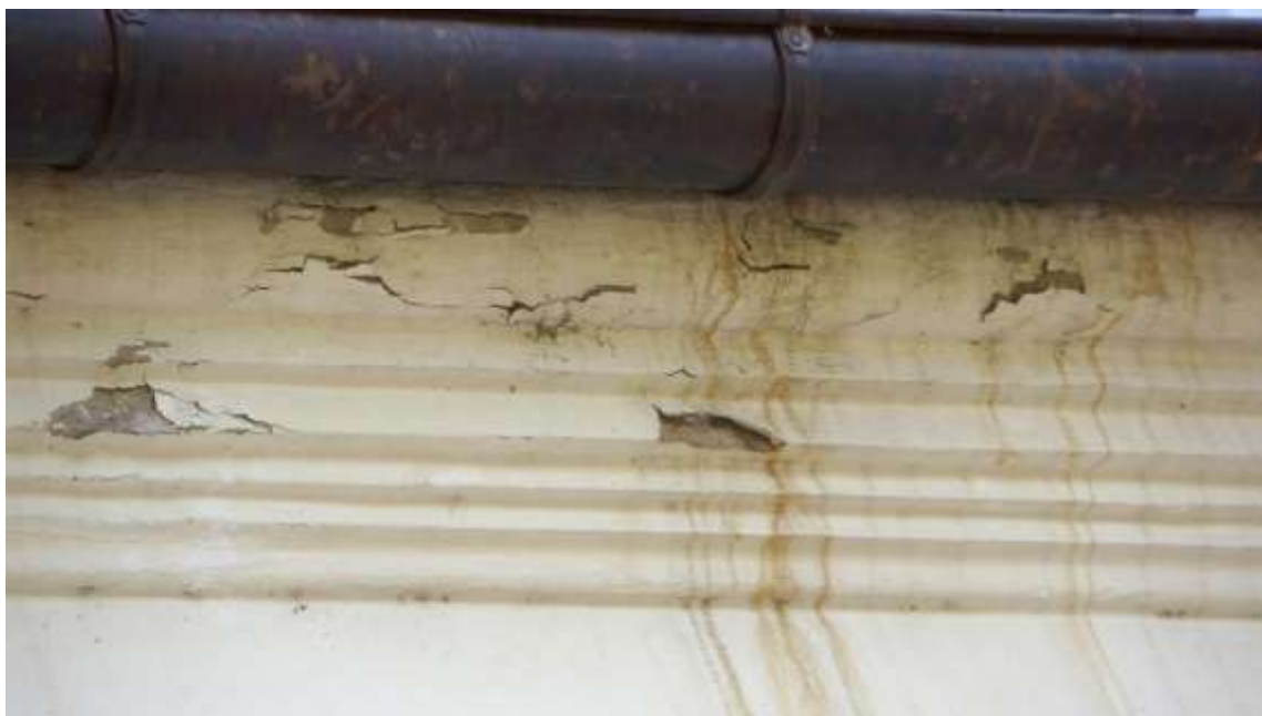
Ubytki i złuszczenia farby na gzymsie pod rynną spowodowane są zawilgoceniem.
