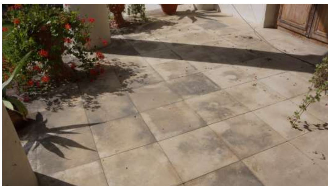
Płyty na tarasie wymagają oczyszczenia oraz impregnacji
